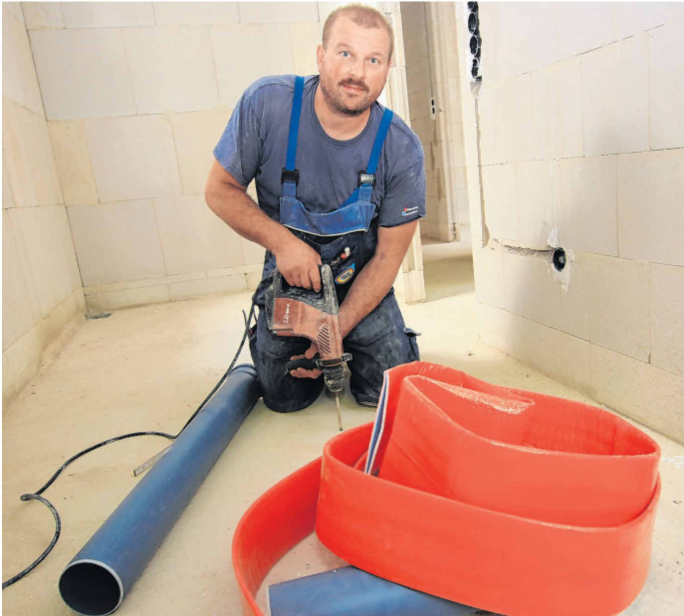
Auf einer Baustelle: Installateur Guido Kämper bereitet den Einbau von Abwasserrohren vor.
